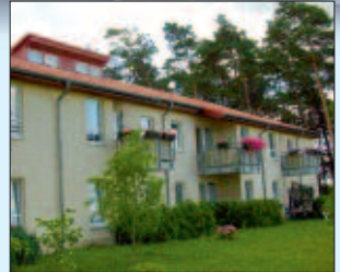
■ In Wildau wurde von den Fachleuten ein Seniorenheim mit 24 Wohneinheiten errichtet.
