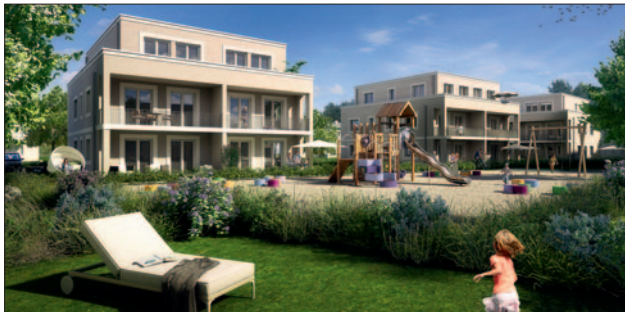
■ In Wildau entsteht ein neues, attraktives Wohnquartier.
